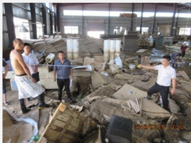
图片描述：红杉木业厂房受灾严重，查勘员第一时间赶赴现场查勘。
