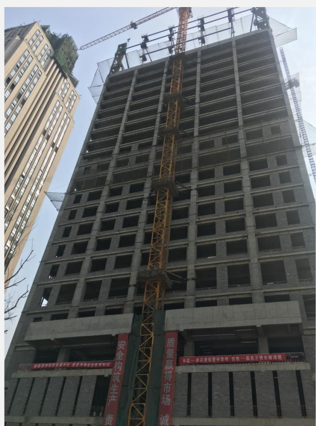
图片描述：中华保险大厦施工现场
